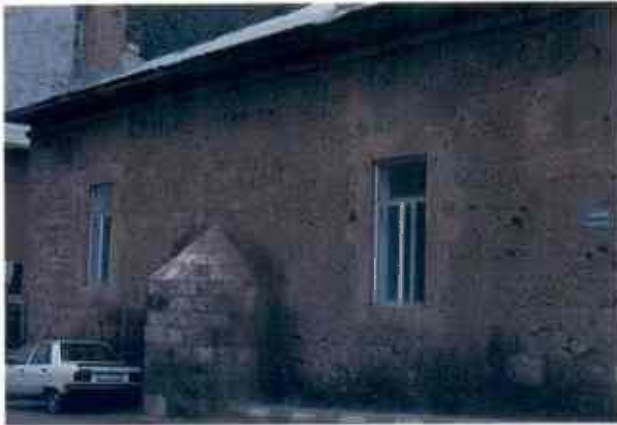
Resim 58 : İspir Tuğrulşah Camii Güney Cephe
