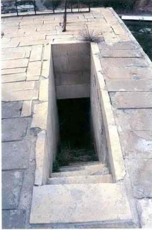
Resim 46 : İspir Kale Mescidi'nde Çatıdan Çilehaneye İniş Sağlayan Merdiven
