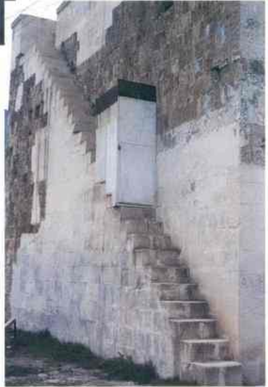
Resim 45 : İspir Kale Mescidi Doğusunda Yer Alan ve Çatıya Ulaştıran Merdiven
