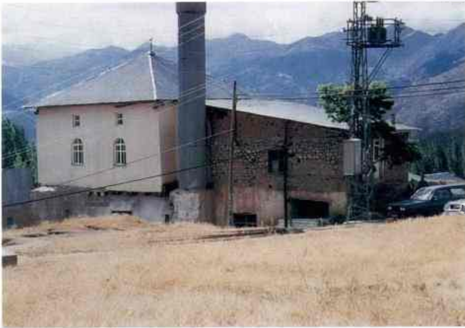
Resim 64 : İspir Numan Paşa Camii
