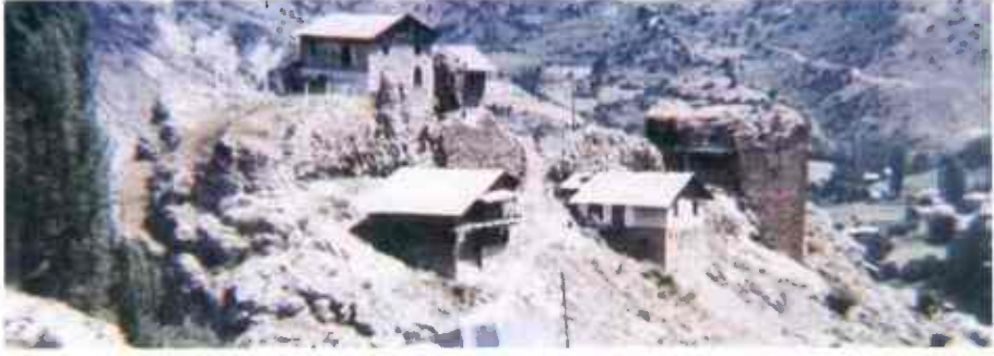
Resim 20 : Fısırik Kalesi Güneyden Bir Görünüm
