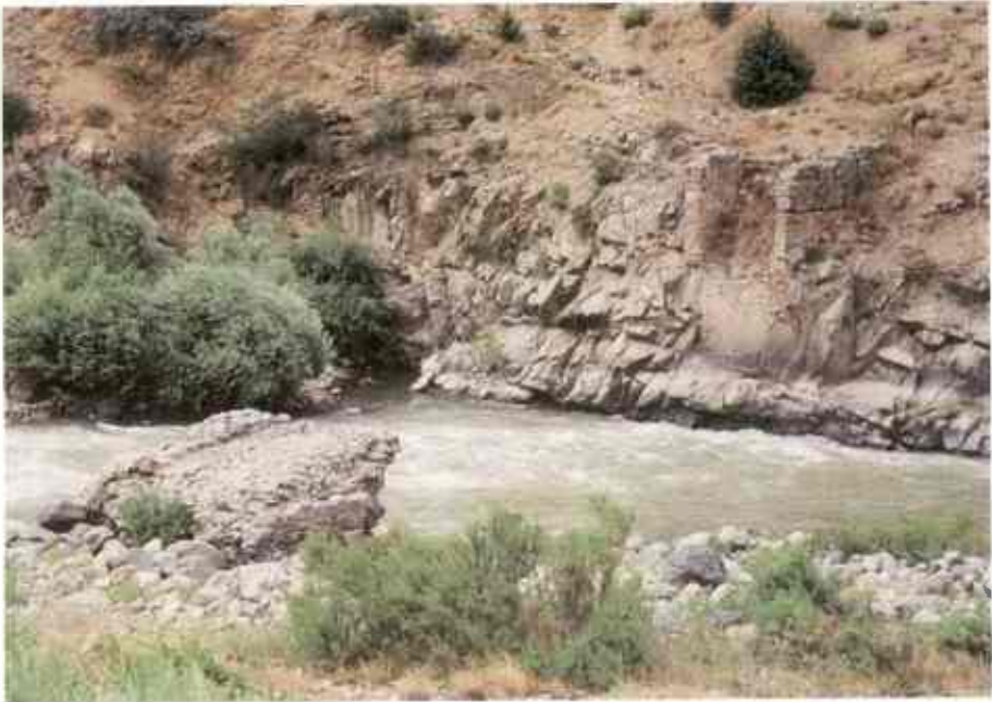
Resim 72 : Numan Paşa Köprüsü
