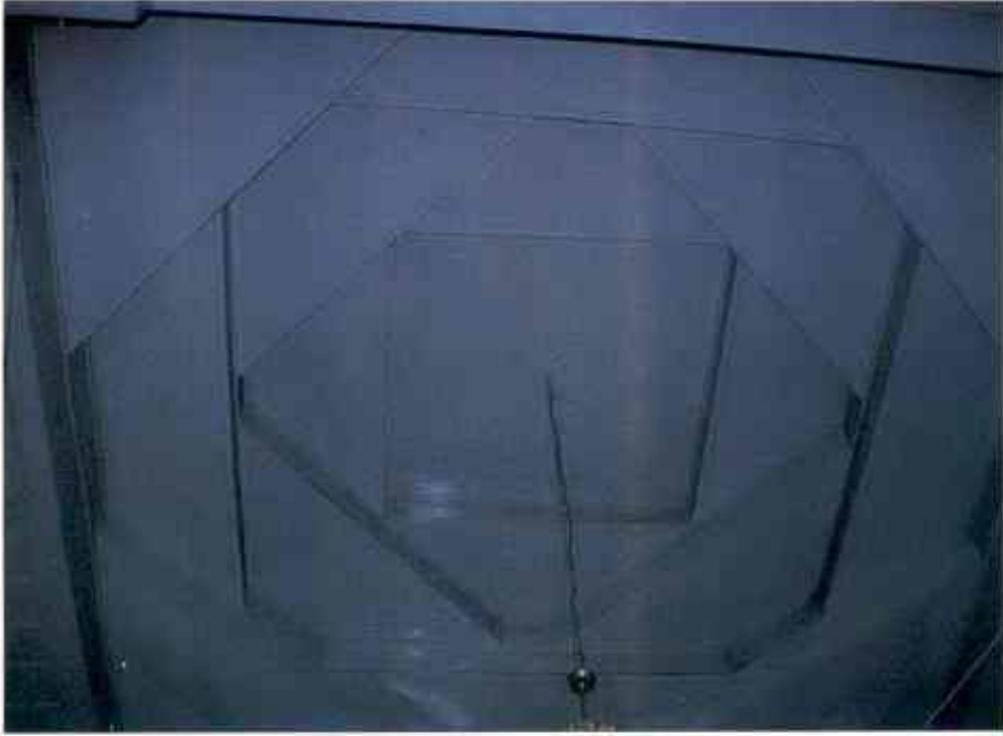
Resim 56 : İspir Tuğrulşah Camii'nde Kırlangıç Örtü
