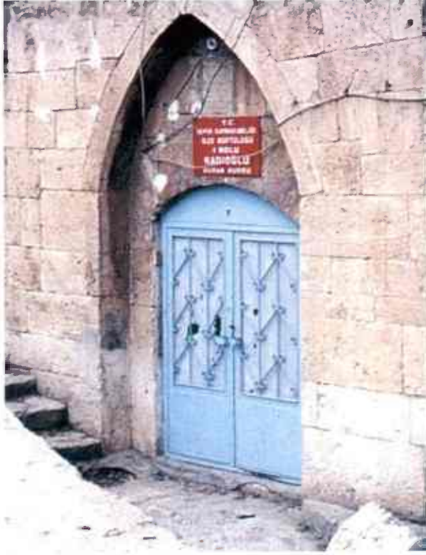
Resim 68 : İspir Kadiođlu Medresesi Giriş Kapısı
