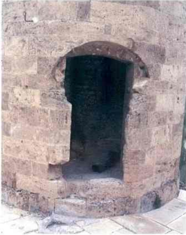
Resim 51 : İspir Kale Mescidi Minare Girişi
