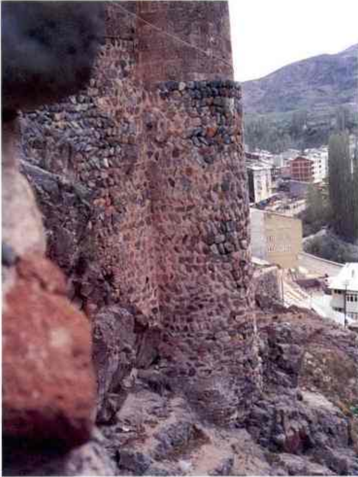
Resim 49 : İspir Kale Mescidi Güneybatı Köşesinde Minare Kaidesi
